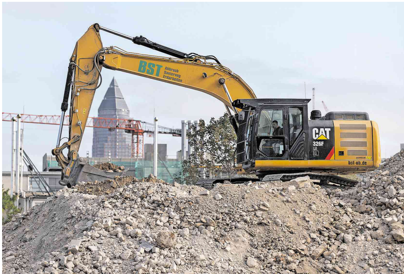
Der Abriss hat schon begonnen: Bagger schaffen an der Kleyerstraße Platz für 1300 Wohnungen.
